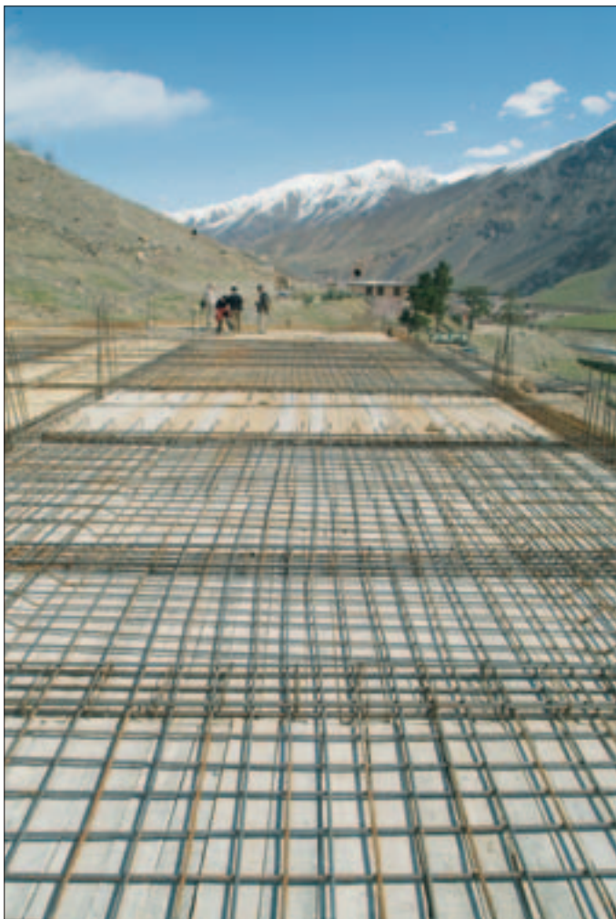
Die Bewehrung ist fast fertiggestellt
