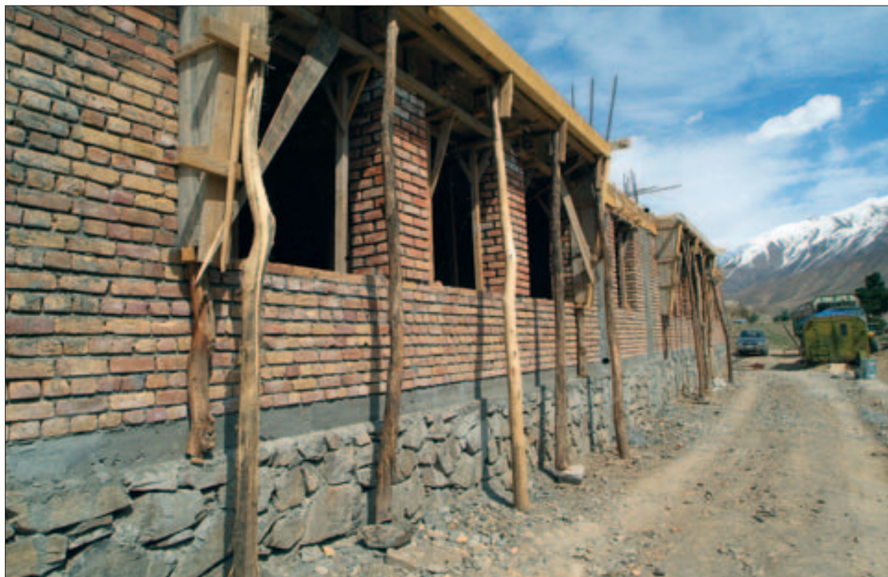
Die seitlichen Holzverschalungen werden zu Betonvorsprüngen, die Schatten spenden und vor zu großer Hitze in den Klassenräumen schützen
