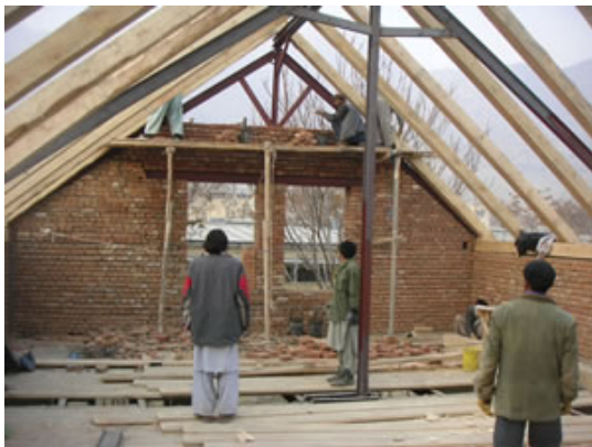
Bauarbeiten am Obergeschoß
