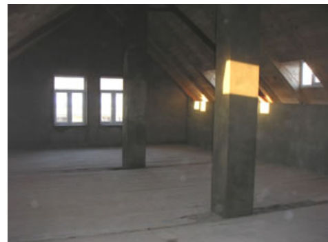
Das neue Obergeschoß
