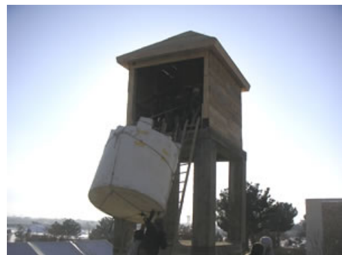
Der Wassertank wird auf den Turm gezogen
